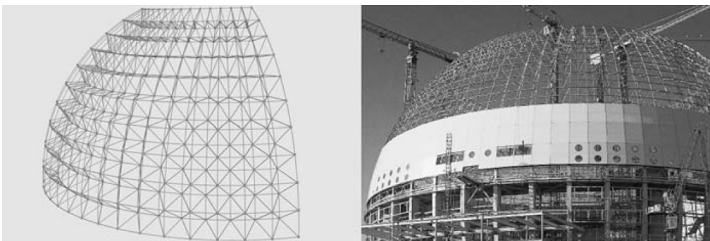
Abbildung A.2: Schalenförmiges Raumtragwerk (PECH et al. [65])
