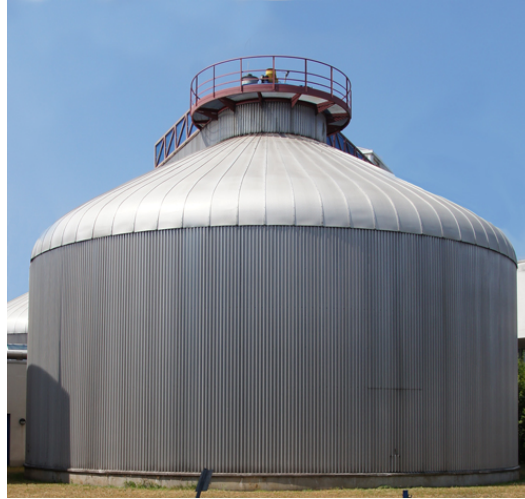
Abbildung 5.4: Faulturm der Kläranlage Saarbrücken-Burbach. 14
