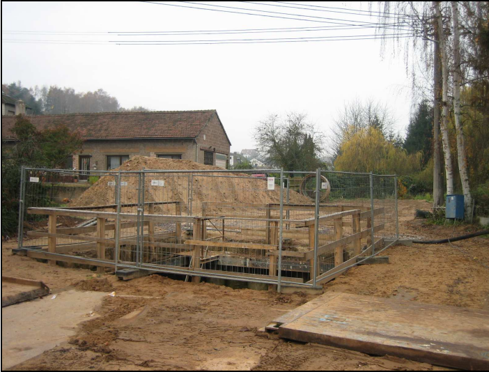
Abb. 18: Exemplarische Aufnahme einer der Start- bzw. Zielgruben für den grabenlosen Leitungsbau, wie sie im zweiten Bauabschnitt bei der Verlegung des Abwasserkanals erforderlich wurden. Die Gruben besitzen eine Länge und Breite von über 5 m und eine Tiefe von rd. 10 m. Die hier abgebildete Grube östlich der Denkmalstraße wurde bereits ca. 20 m innerhalb der Wasserschutzzone II errichtet. Der nächstgelegene Brunnen Differten 5 liegt rd. 330 m entfernt. Im ausstehenden dritten Bauabschnitt wird der Abwasserkanal nur rd. 2 m tief verlaufen.
