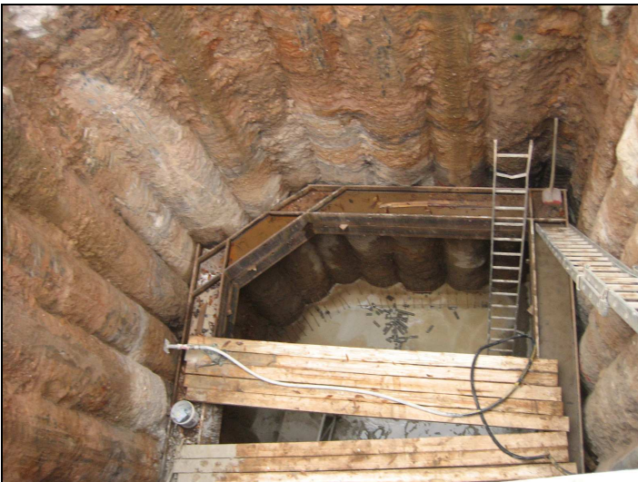
Abb. 19: Blick in eine der Start- und Zielgruben. Zur Gewährleistung der Standsicherheit wurden die Gruben randlich mit einer Betonierung versehen und mittels passgenauer Stahlträger verstärkt. Die Bist wird von der Kanaltrasse mehrfach gequert, was infolge der Tiefenlage des Abwasserkanals kein größeres Problem darstellt. Die einzelnen Baugruben werden über Pumpen im Sumpf wasserfrei gehalten. Im dritten Bauabschnitt wird der Abwasserkanal aufgrund dessen dort deutlich geringeren Tiefenlage in offener Bauweise realisiert werden.
