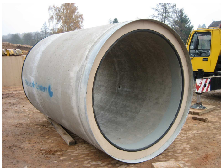
Abb. 23: Nahaufnahme eines der zum Einsatz kommenden Zwei-Schicht-Stahlbetonrohres mit Korrosionsschutz der Nennweite DN 1.800, in das später ein Kunststoffrohr DN 315 zur Abführung des kritischen Abflusses eingezogen wird. Im dritten Bauabschnitt werden geringer dimensionierte Rohre mit Nennweiten zwischen DN 400 und DN 700 zu Einsatz kommen. Rohre mit erhöhtem Sicherheitsstandard zur Gewährleistung eines vorsorglichen Grundwasserschutzes wurden seitens der zuständigen Fachbehörde als zwingend erforderlich angesehen.
