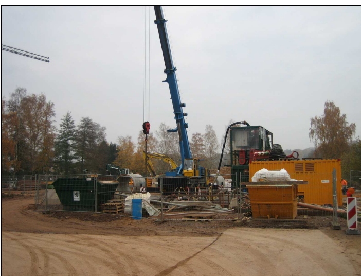
Abb. 20: Baustelleneinrichtung im Umfeld einer Baugrube im Bereich des Festplatzes westlich der Denkmalstraße. Zu sehen ist der Kran, über den die Kanalrohre in die Startgrube hinabgelassen werden. Des Weiteren sind verschiedene Lagerplätze für Material und Maschinen zu erkennen sowie der Container der örtlichen Bauleitung. Die Bist verläuft unmittelbar rechts am Bildrand. Am Festplatz wird neben einem Pumpwerk auch ein Regenüberlauf zur Kanalentlastung im Bedarfsfall errichtet.
