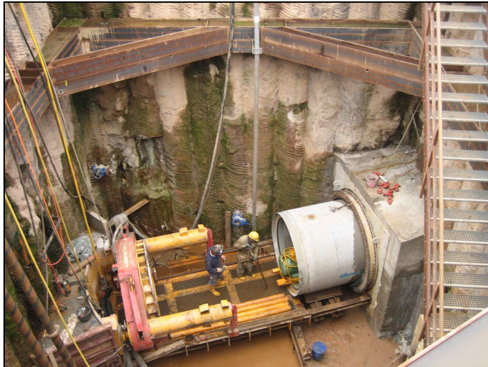
Abb. 21: Aufnahme der im zweiten Bauabschnitt zum Einsatz gekommenen Rohrvortriebsmaschine. Die einzelnen Rohre werden hydraulisch hinter dem Bohrkopf in die entstandene Bohrung eingebracht. Eine zusätzliche künstliche Bettung ist nicht gegeben. Zur Schmierung der Rohre wird eine Bentonit-Suspension zwischen Rohraußenwand und Gebirge eingepresst.
