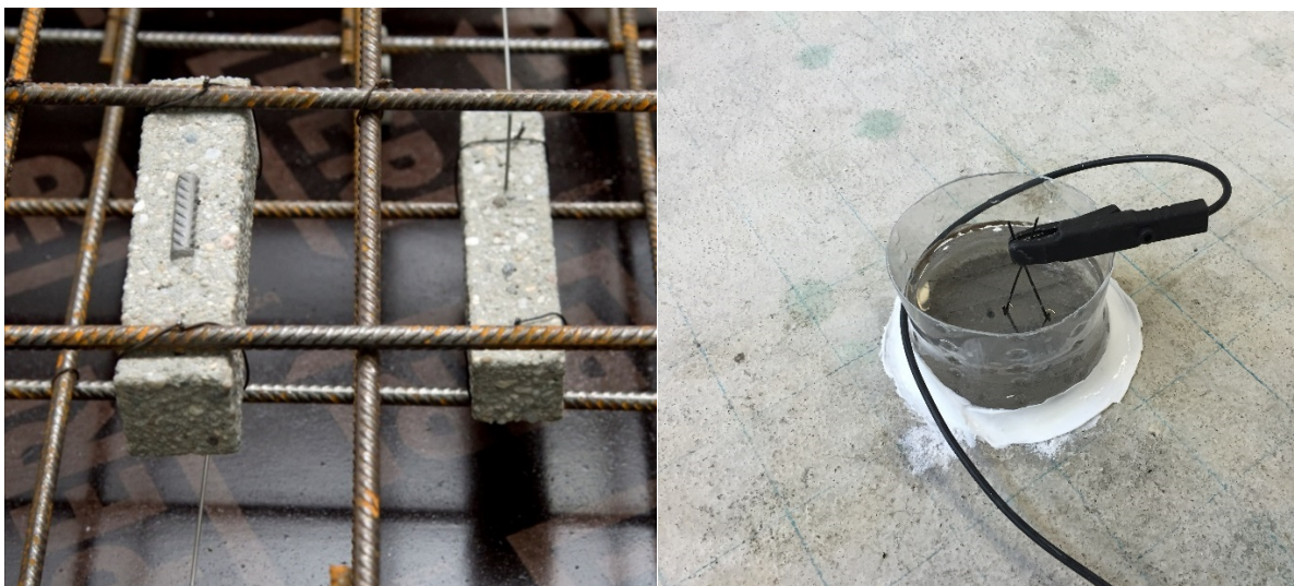
Abbildung 4-6: Korrosionsinitiierung; Links: Elektroden mit Edelstahlschweißdrahtanschluss; Rechts: Salzwasserbad mit Mangan-Mischoxid-Netz in Salzwasserlösung.
