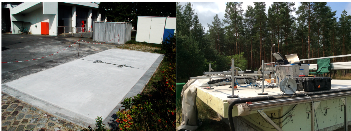
Abbildung 3-1: Links: Ansicht des Prüfobjektes „Großer Betonprobekörper“ (GBP); Rechts: Ansicht des Prüfobjektes All Inclusive (AI).
