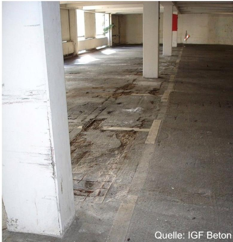
Abbildung 2-3 Parkdeckoberfläche mit offenen Schäden durch Korrosion der Bewehrung.
